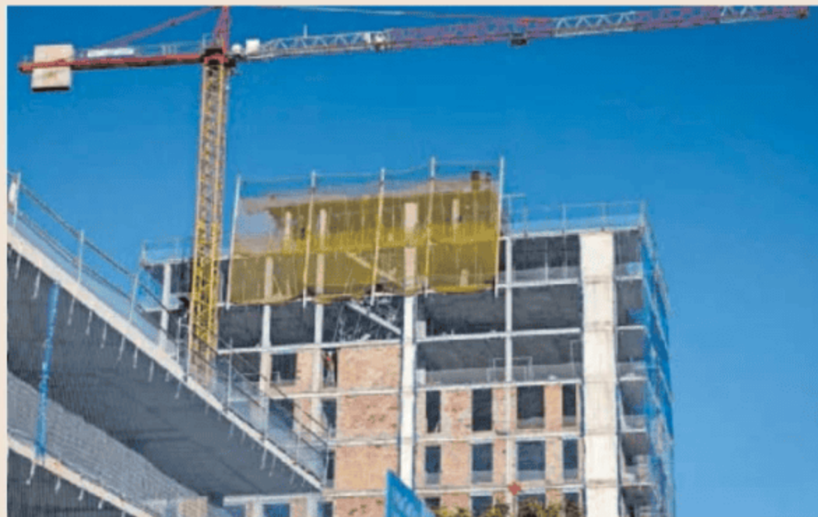
Construcción de vivienda nueva en La Marina de Port de Barcelona. MASSIMILIANO MINOCRI
